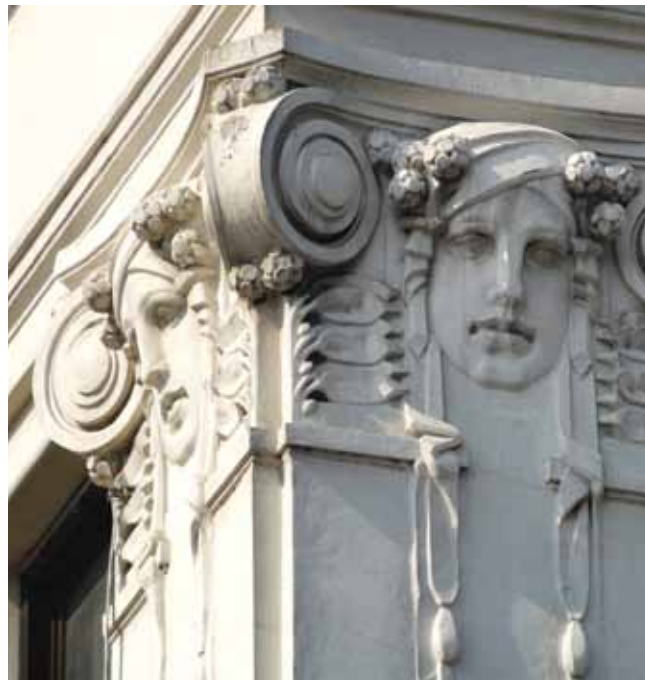
Cesarsko kraljeva državna obrtna šola – detajl fasade / Imperial Royal State School of Crafts – detail of the façade
